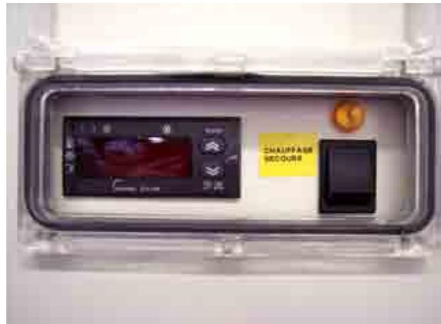
In der Not-Position (orangefarbene Anzeigelampe „Notbetrieb“ leuchtet) erfolgt das Einschalten der zusätzlichen Heizwiderstände nur aufgrund der Anforderung der Zusatzheizung durch den Regler über das Wassergesetz.
