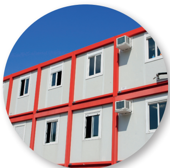
Constructions modulaires de chantier.
