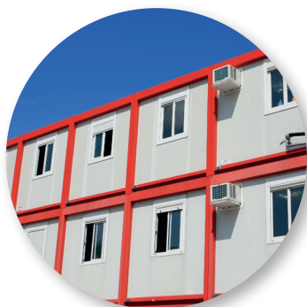
Constructions modulaires de chantier.
