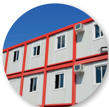
Constructions modulaires de chantier.
