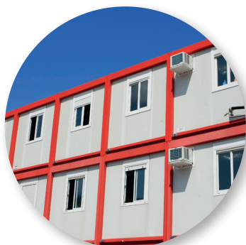
Constructions modulaires de chantier.
