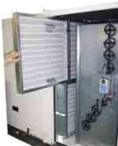
Verificare che la superficie delle alette in alluminio dello scambiatore non sia stata danneggiata da colpi o graffi, e se necessario, pulirla con l'apposito utensile.
