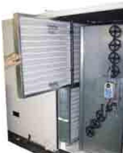
Prüfen, dass die Aluminiumlamellen des Wärmetauschers nicht durch Stöße oder Schrammen beschädigt sind und sie, falls notwendig, mit einem geeigneten Kamm richten.
