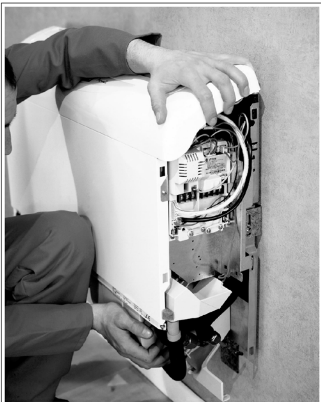
Монтаж на стене
