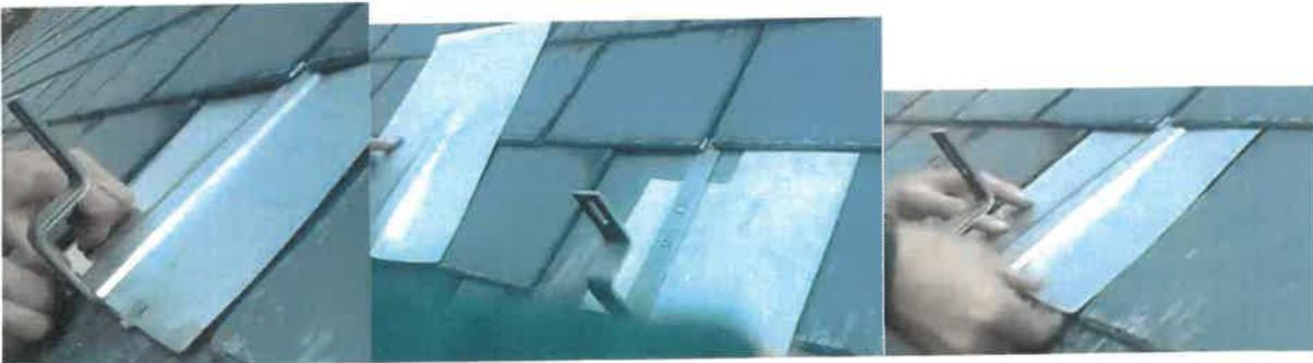
La pente de toiture doit être limitée à 60° (173%) et doit respecter les règles de mise en œuvre de couvertures en ardoises.
