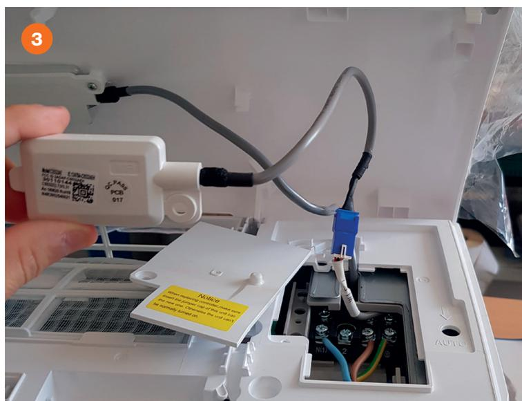
Pour terminer cette installation, placer le module WIFI dans l'**emplacement dédié**, utiliser la vis fournie avec le kit pour le fixer puis refermer le capot du bornier électrique.
