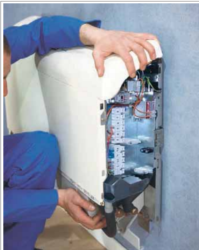
MONTAJE EN SUELO
