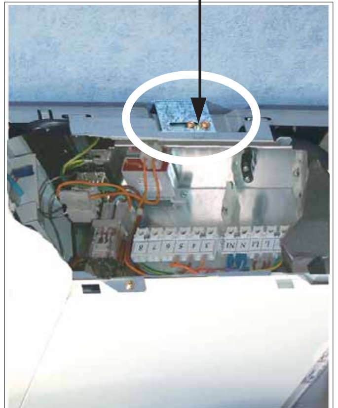
MONTAJE EN TECHO
