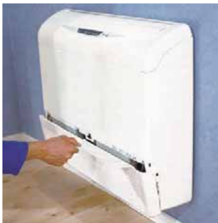
Accès au filtre
