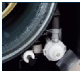
Pompe de relevage de condensat en série. Hauteur de relevage jusqu'à 600 mm. 1 seul point de fixation pour faciliter la maintenance.
